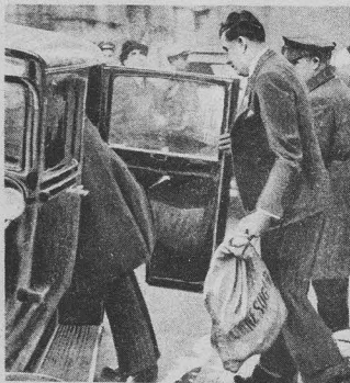
Un detective conduciendo el saco lleno de botellas vacías con el que los salteadores querían hacerse pasar por contrabandistas de licor, en la residencia de Mr. Glemby.
